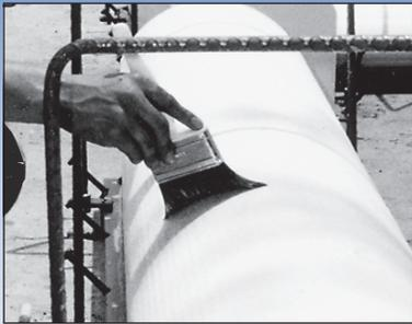
**Agent de démoulage** - L'agent de démoulage est un produit sans pétrole qui doit être appliqué sur toutes les surfaces PSE. Ce produit est idéal au démoulage du béton sans attaquer la mousse PSE. L'agent de démoulage s'applique davantage avec un pinceau et est disponible en 1 ou 5 gallons.
